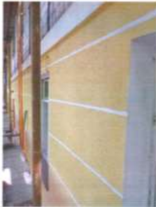
Строительный объект после завершения первого этапа ремонтных работ (школьный этаж).
